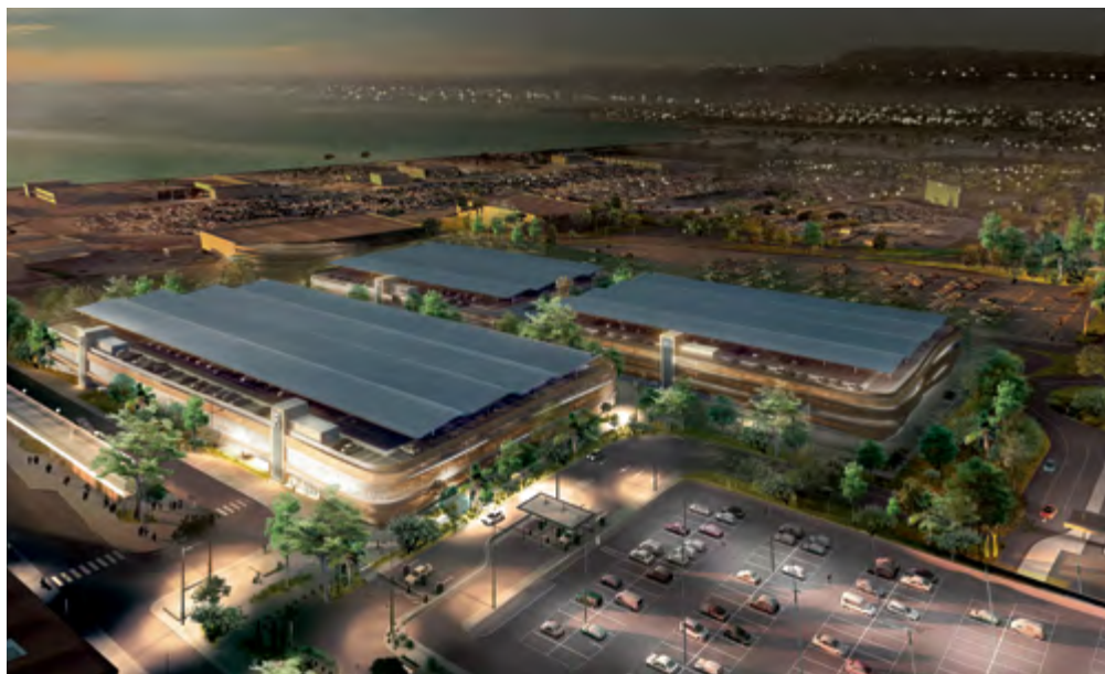
AÉROPORT MARSEILLE PROVENCE
